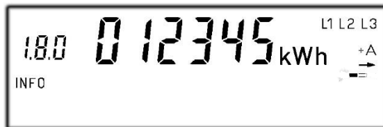
Betriebsanzeige vom Display
